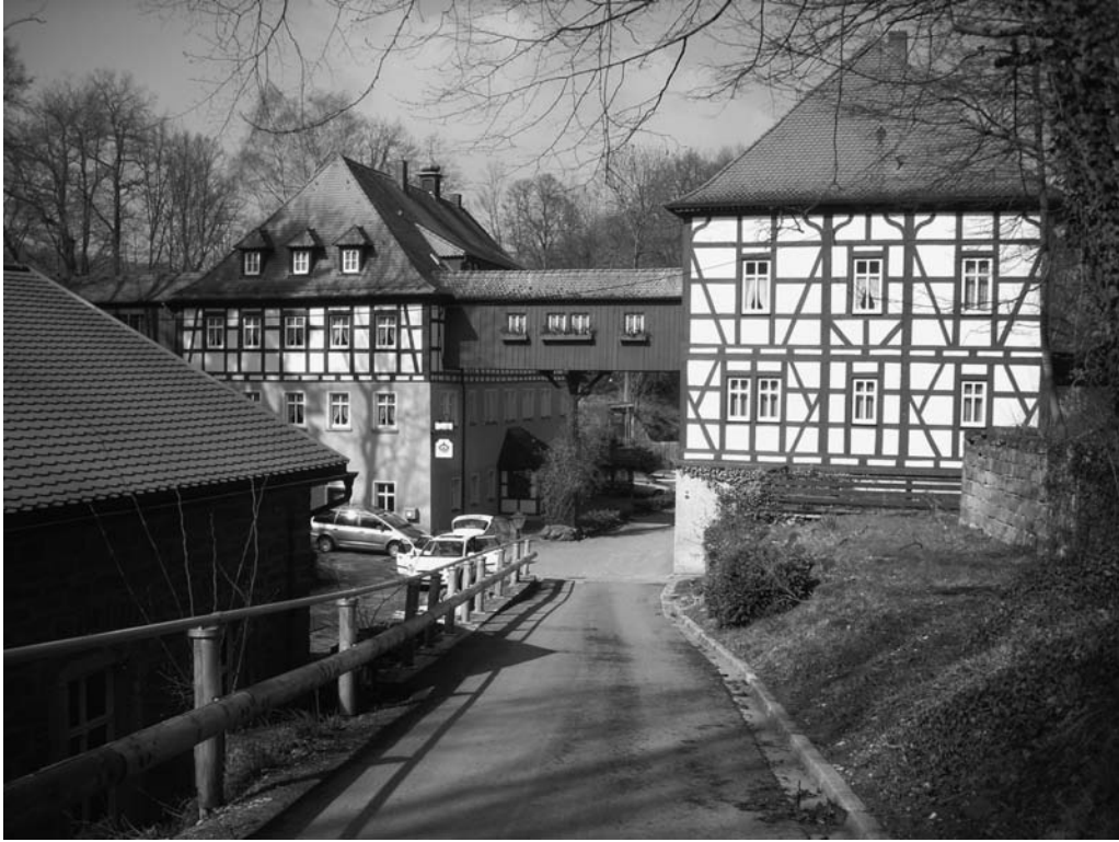
1 Wildbad Burgbernheim. Blick auf die erhaltenen Bauten des Gesundbrunnens: Das Hauptgebäude ist im massiven Teil 1621 datiert, während das Obergeschoß aus Fachwerk um 1700 entstand. 1718 wurde das danebenstehende Gebäude durch Markgraf Georg Wilhelm vom Bayreuth errichtet, das offenbar vor allem Wohnzwecken für die Kurgäste diente. Foto Verfasser, 2008.
